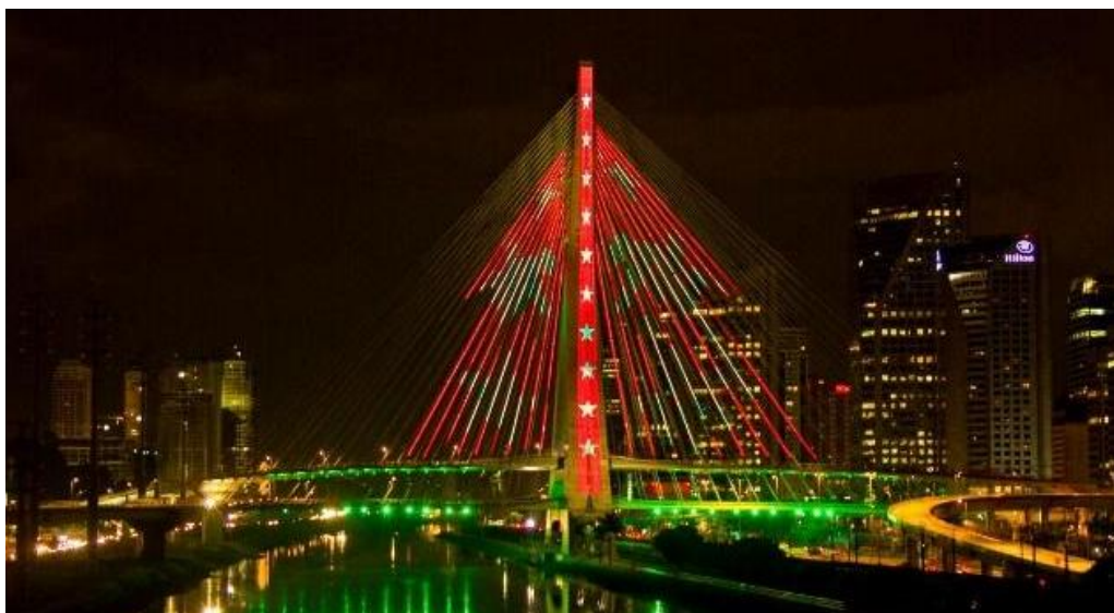
FIGURA 1 – Ponte Estaiada Octávio Frias de Oliveira no Natal em 2010. Fonte: Disponível em: < https://onprojecoes.com.br/Natal-Ponte-Estaiada >. Data do acesso: 16/01/026
